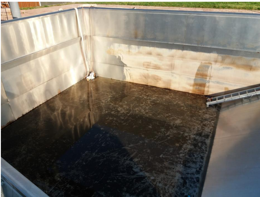
Sprungbecken nach der Überwinterung und Abpumpen des Wassers
